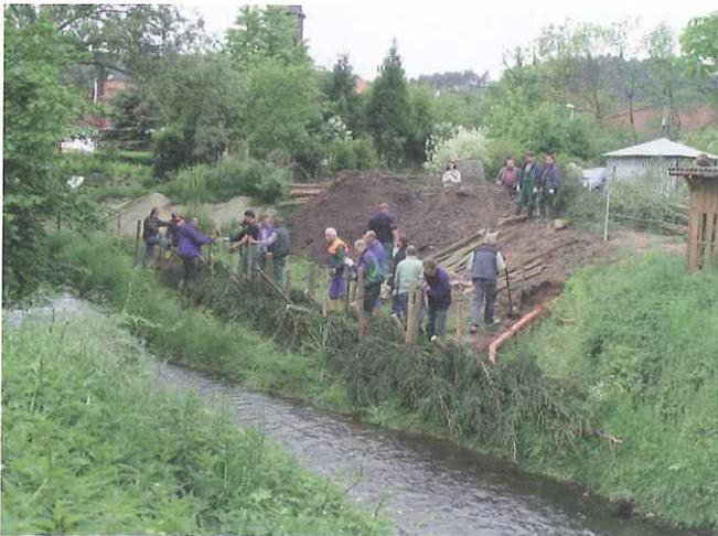
Bild 16: Befestigung der ersten Lage Raubbäume durch Fichtenpflöcke und Weidensetzstangen (Foto: Herr Dittrich)
