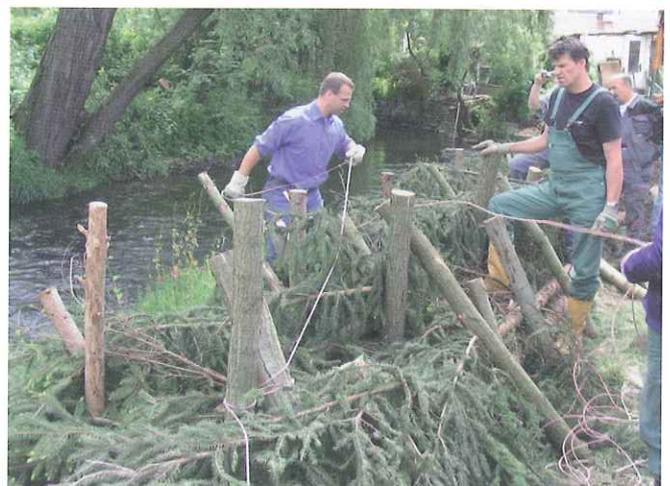
Bild 17: Seilsicherung der Raubbäume, die dann an einem Pfahldreibock befestigt wird. (Foto: Herr Dittrich)
