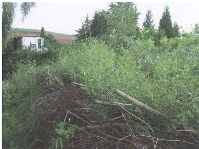
Bild 21: Detailaufnahme austreibender Weiden aus der Buschlage, Mitte Sept. 2009 (Foto: Herr Dittrich)
