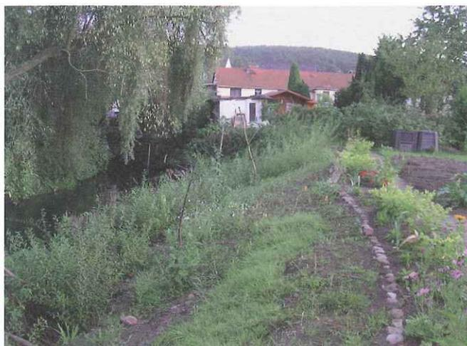
Bild 20: Kolkverbau Mitte Sept. 2009. Blick entgegen der Fließrichtung. Deutlich erkennbar im Vordergrund die austreibenden Weiden der Buschlage (Foto: Herr Dittrich)
