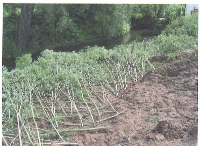
Bild 19: Buschlage, kreuzweise versetzt in zwei Lagen eingebaut, vor der Überschüttung. (Foto: Herr Dittrich)
