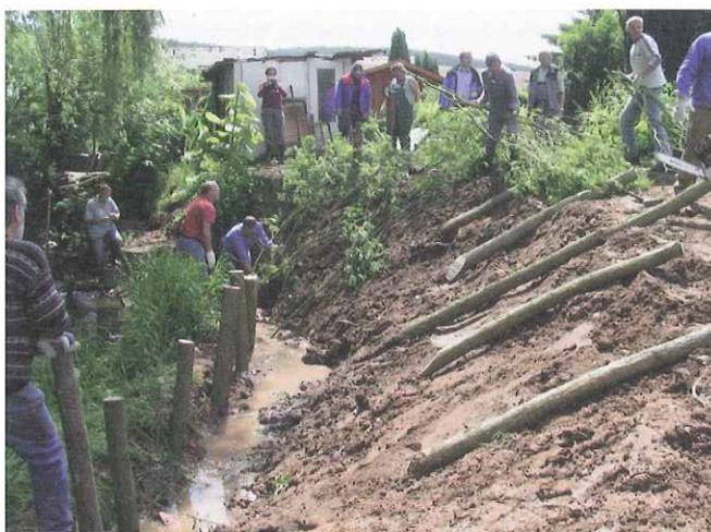
Bild 9: Beginn des Spreitlagenbaus: Graben am Böschungsfuß ist ausgehoben, Böschung planiert und Verlauf der zukünftigen Uferlinie abgesteckt. Die Weidenäste werden möglichst tief unter die Niedrigwasserlinie eingesteckt und die Böschung flächig mit Weidenästen abgedeckt (40 bis 50 Äste pro Laufmeter).
