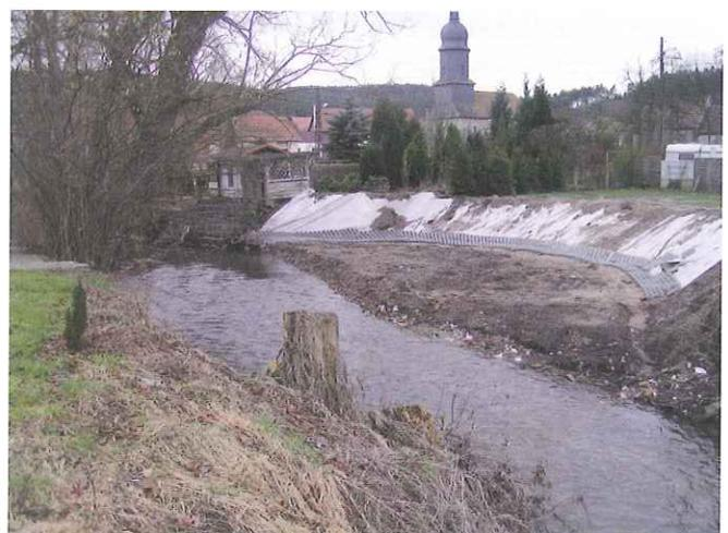
Bild 4: Der Kolk am 21.01.08. Deutlich erkennbar ist das Ausmaß des Abbruches. Blick vom Gegenufer entgegen der Fließrichtung. (Foto: Herr Dittrich)
