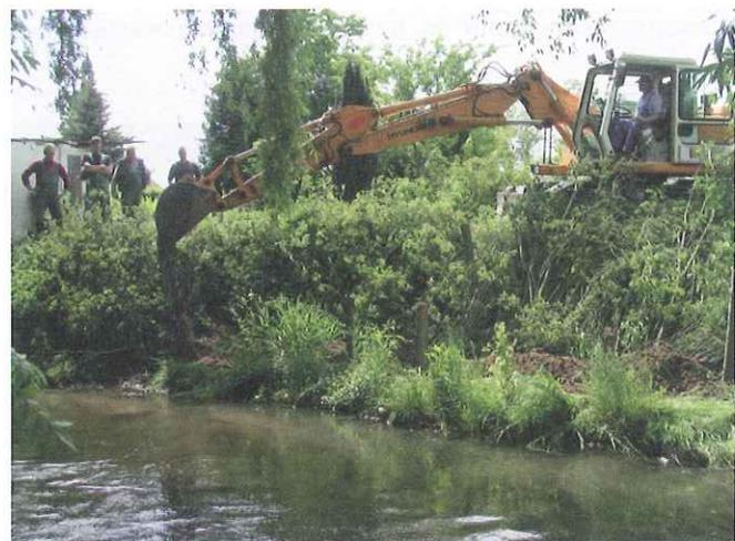
Bild 10: Weidenspreitlage – Nach Einbau der Weidenäste erfolgt die Verfüllung des Grabens am Böschungsfuß.
