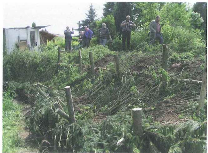
Bild 12: Weidenspreitlage nach Übererdung – als letzter Arbeitsschritt müssen noch die Pfähle bis auf 10 cm über der neuen Böschungsoberkante abgesägt werden. (Foto: Herr Dittrich)
