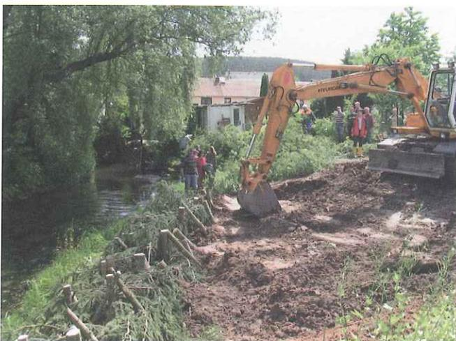
Bild 18: Im Zuge der Verfüllung des Kolks wird im Anschluss an die Fußsicherung durch Raubbäume eine Berme zum Einbau der Buschlage profiliert (Foto: Herr Dittrich)
