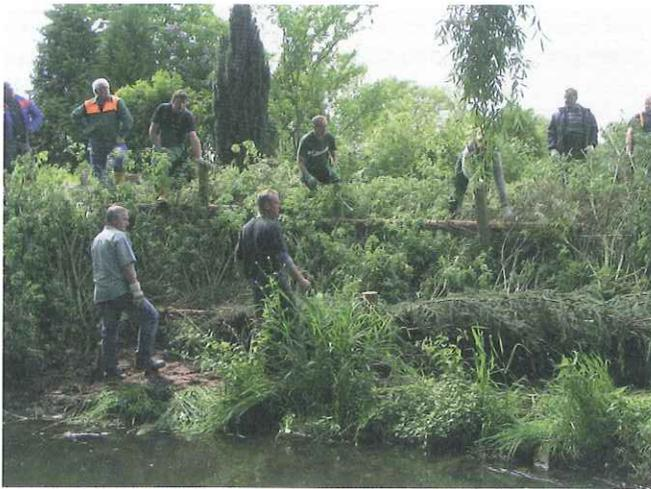
Bild 11: Nach Fertigstellung der Weidenspreitlage: Einbau der Raubäume zur Böschungsfußsicherung. (Foto Herr Dittrich)
