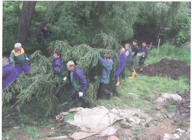
Bild 15: Einbau der ersten Lage Raubbäume (Foto: Herr Stowasser)
