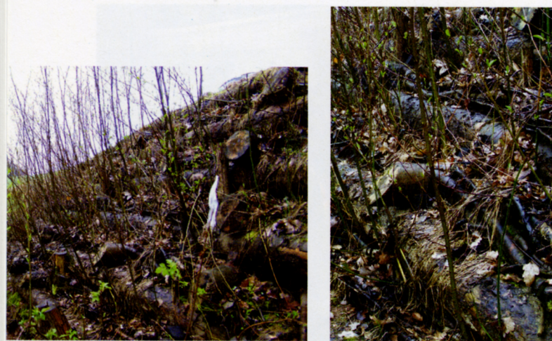
Abb. 12: Holzkraierwand mit Heckenlagen und Totfaschinen am Beginn der dritten Vegetationsperiode – der gleichmäßige Austrieb der Heckenlagen aus Schwarzerle, Gemeiner Esche und Pfafenhütchen erfordert noch keinen Pflegeschnitt.
