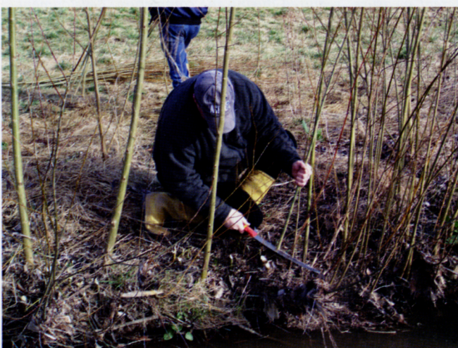
Abb. 7: Selektiver Rückschnitt eines zweijährigen Weidenbestands, hervorgegangen aus einer Uferfaschine. Nur die kräftigsten Weidentriebe bleiben als Zukunftsbäume (im Foto links) erhalten. Welcher der drei Triebe letztlich zu einer Baumweide heranwachsen darf, wird im Zuge der nächsten Pflegegänge zu entscheiden sein.
