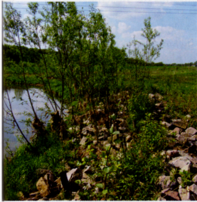
Abb. 15: Erster Pflegeschnitt einer begrünten Steinschüttung mit Heckenbuschlagen am Lungwitzbach (Sachsen) zu Beginn der dritten Vegetationsperiode: Die Buschlage entlang der Böschungsoberkante wurde selektiv zurück geschnitten, um den Aufwuchs aus der Heckenlage (hier Schwarzerle und Traubenkirsche) zu fördern.
