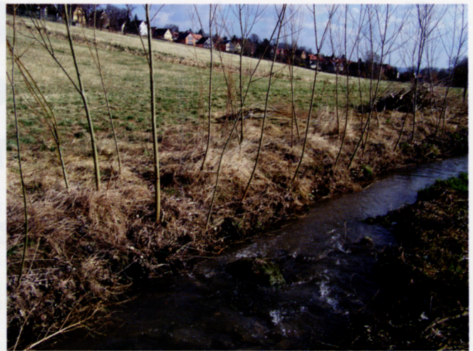
Abb. 8: Weidenbestand aus einer Uferfaschine mit anschließendem Steckholzverband nach Abschluss des ersten Pflegeganges (selektiver Rückschnitt)
