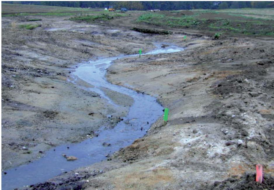
Abb. 4: Gewässerbett nach Abschluss der Profilierungsarbeiten
