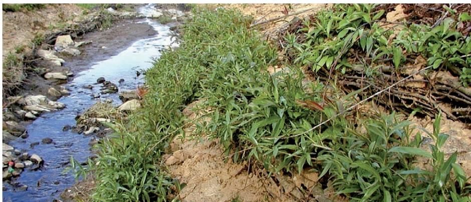
Abb. 8: Austrieb einer Lebendfaschine auf Buschlage vier Wochen nach Baufertigstellung (Ende April 2001)
