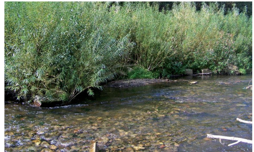
Abb. 14: Blick vom gegenüber liegenden Ufer auf die Ufersicherung aus den Abbildungen 11 – 14 im September 2009. Trotz intensiver Uferbefestigung sind knapp zwei Jahre nach Baufertigstellung naturnahe Ufer- und Sohlstrukturen entstanden. Deutlich zu erkennen ist die abwechslungsreiche Gewässersohle mit dem Kolk am Bühnenkopf und die kiesige Auflandung im Bühnenfeld (vgl. Abbildung 11).
