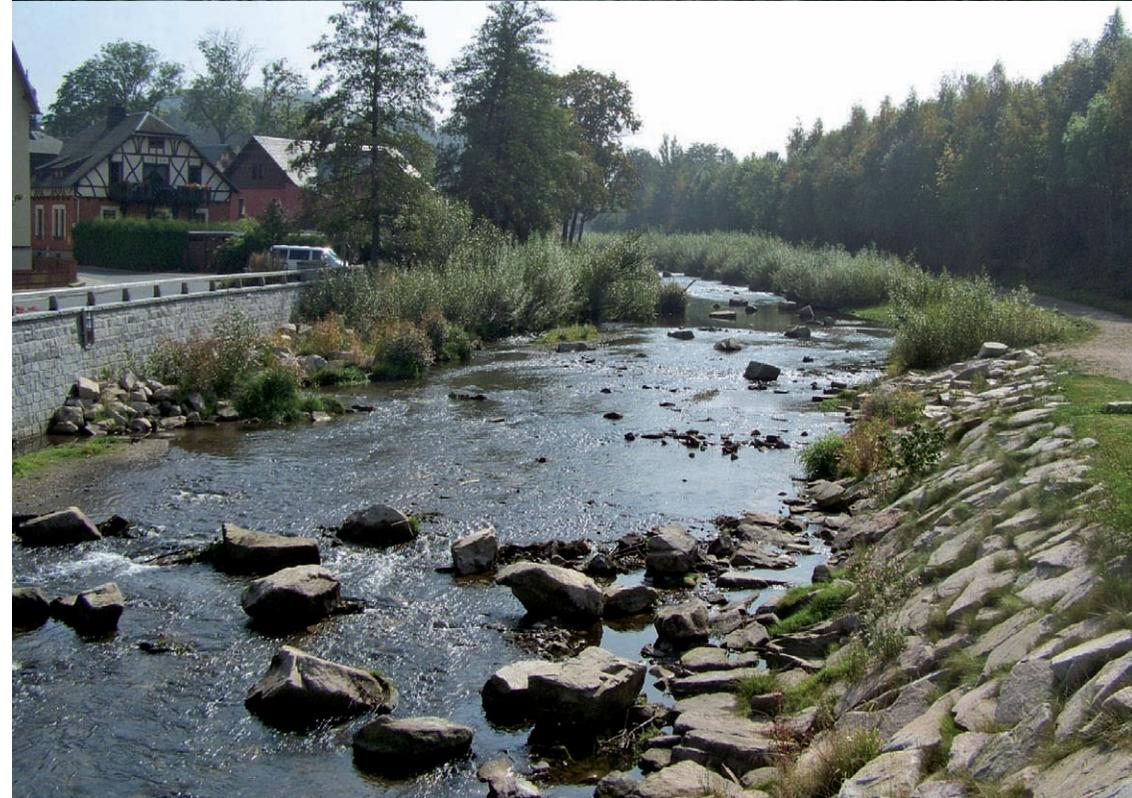
tet, dass deren ohnehin stark reduzierte Nutzung vollständig aufgegeben wurde. Die Große Mittweida war weder erlebbar noch zugänglich und wies daher keinerlei Erholungseignung auf. Von Juni bis Dezember 2007 wurde der naturnahe Rückbau der Großen Mittweida in Schwarzenberg auf einer Länge von knapp einem Kilometer ausgeführt. Pro Laufmeter betragen die Baukosten (ohne Altlastensanierung) ca. 1.937 €.
