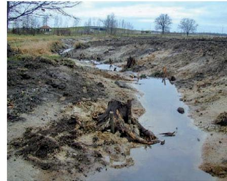
Abb. 5: Wurzelstubben kombiniert mit austriebsfähigen Weidensteckhölzern,
