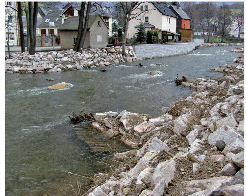
Abb. 13: Lebenduhnen in Kombination mit begrünter Steinschüttung gewährleisten unmittelbar nach der Baufertigstellung (November 2007) einen intensiven Uferschutz und verbessern gleichzeitig die Gewässerstruktur
