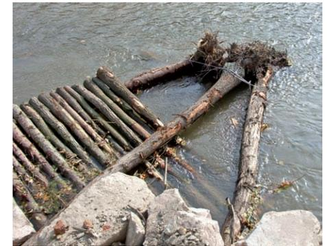
Abb. 12: Lebenduhne mit Fischunterstand im Bauzustand – September 2007
