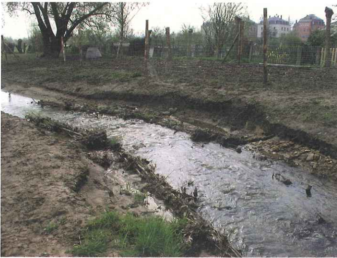
Bild 3: April 2006 – Schadbild: Auskolkung am Prallhang mit hinterspülter Faschine (Bild: P. Zinnecker)
