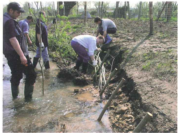
Bild 4: 26. April 2006 – Setzen von Weidenstangen für einen Flechtzaun (Bild: P. Zinnecker)
