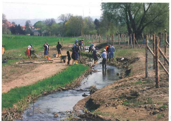
Bild 2: Ufersicherung mittels ingenieurbilogischen Bauweisen am Kaitzbach (Bild: A. Schnauer)
