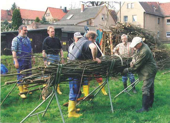
Bild 1: Binden einer Lebendfaschine durch die Teilnehmer des Nachbarschaftstages (Bild: A. Schnauer)
